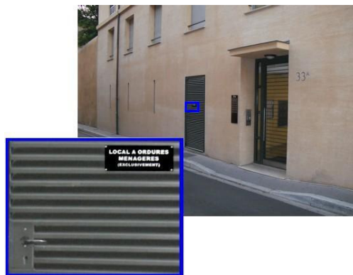
Exemple de local à ordures ménagères intégré dans un bâtiment (Source : Cete Méditerranée)
