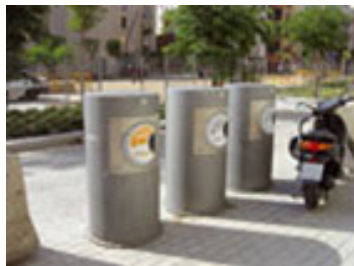
Goulottes pour réseau d'aspiration des déchets ménagers compatible avec le tri sélectif (Source : Cete Méditerranée)
