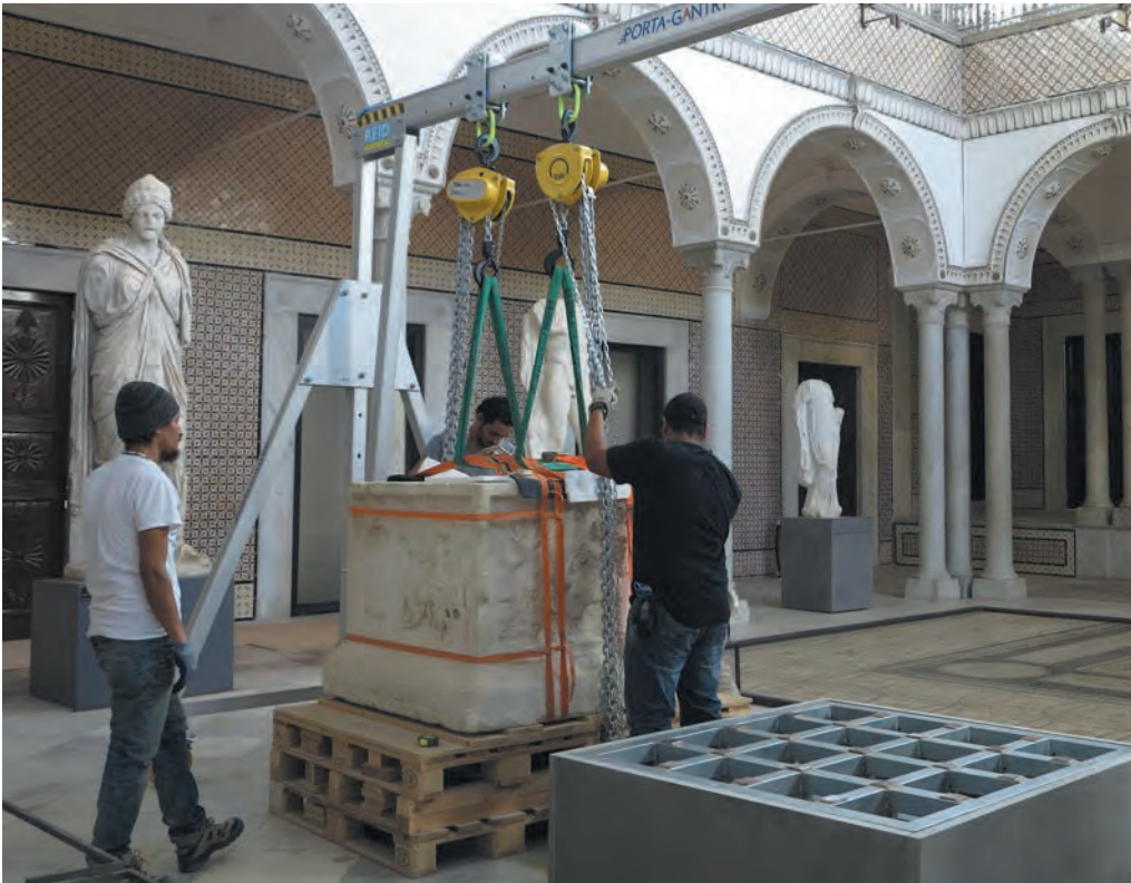
Chantier-école au musée national du Bardo
