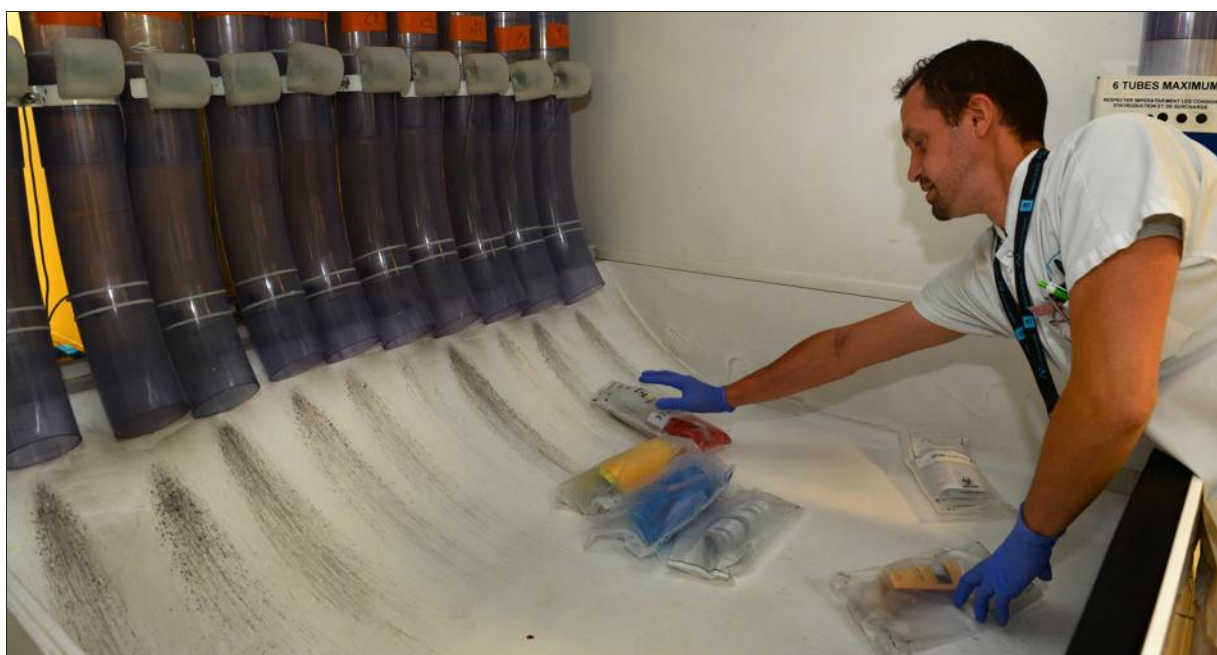
■ Les réseaux pneumatiques de l'hôpital Édouard-Herriot (HEH) et des hôpitaux du groupement Est (ci-dessus) arrivent dans le bâtiment de biologie situé sur le site Est au-dessus d'un bac appelé « la piscine ». Photo Philippe JUSTE
