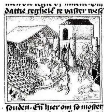
soignée. Plusieurs villes du Nord ont édicté des règlements fixant la taille des briques, mais, dans la plupart des cas, elle faisait l'objet d'un agrément individuel entre le briquetier, le briqueteur, le maître d'œuvre et le maître de l'ouvrage.
