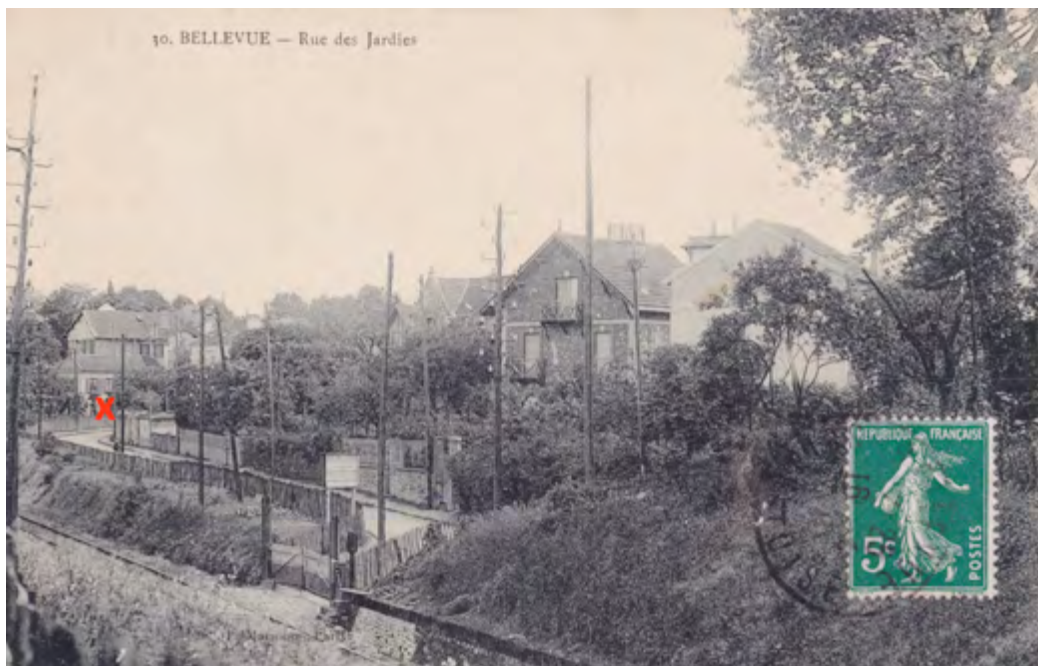
Meudon-Bellevue (Hauts-de-Seine), la rue des Jardies au début du XX e siècle (carte postale ancienne, coll. part.). La croix rouge désigne la maison portant le n° 28, où demeuraient Desvergnès et sa mère. La ligne de chemin de fer menant à Paris (gare Montparnasse) est visible en bas à gauche.
