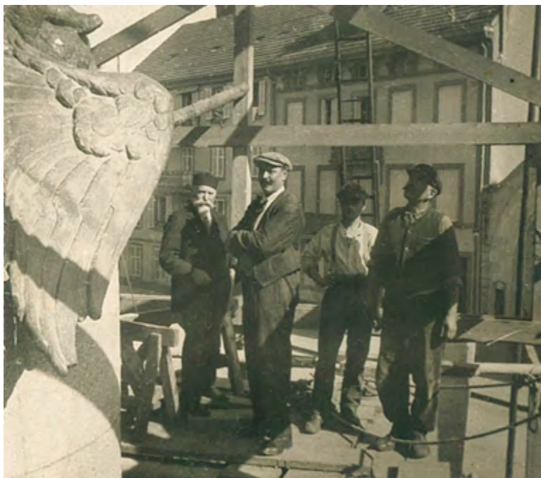
Saint-Dié (Vosges), monument aux morts, Desvergues (à gauche) et les ouvriers des établissements Durenne sur l'échafaudage ayant servi au montage des bronzes, 1927 (coll. part.).
