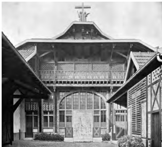
Id. , après achèvement complet des travaux en 1913 ( L'Architecture , 31 janvier 1914, pl. 11).
