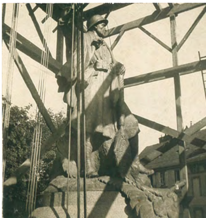
Id. , le poilu du couronnement peu après son installation, 1927 (coll. part.).
