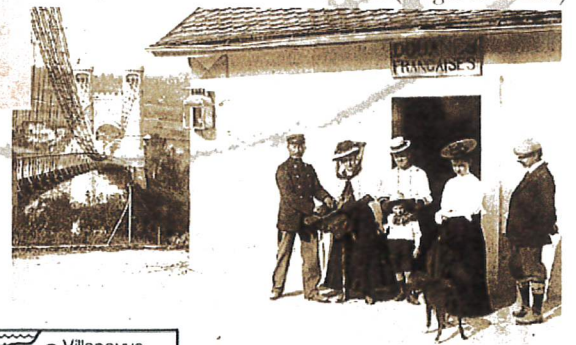
Scène de contrôle au Pont de la Caille (1 re ligne de douane)
