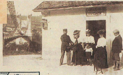
Scène de contrôle au Pont de la Caille (1 o ligne de douane)
